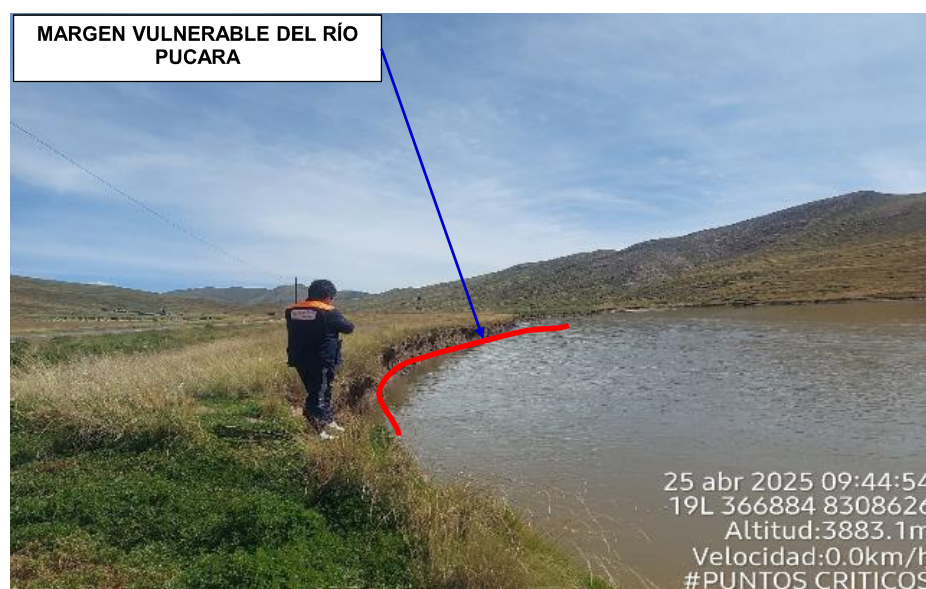
FIGURA N°02: TRAMO CRÍTICO EN EL RÍO PUCARA RIESGO DE EROSION DE LA RIBERA EXPONIENDO LA PRINCIPAL VIA ASFALTADA PANAMERICANA SUR, EN EL SECTOR CAMAQUEN, DISTRITO DE CALAPUJA, PROVINCIA DE LAMPA - PUNO.
