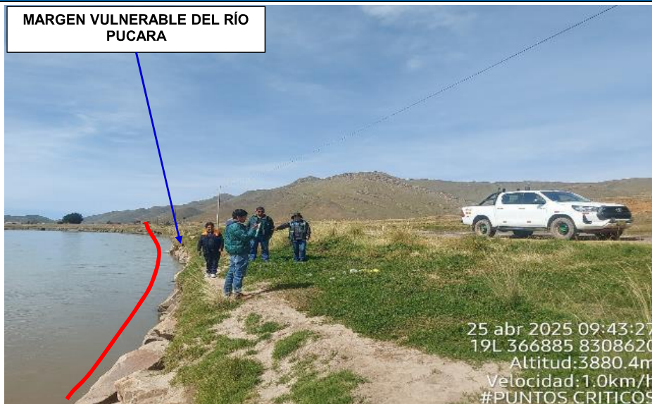
FIGURA N°01: TRAMO CRÍTICO EN EL RÍO PUCARA RIESGO DE EROSION DE LA RIBERA, DISTRITO DE CALAPUJA, PROVINCIA DE LAMPA - PUNO.
